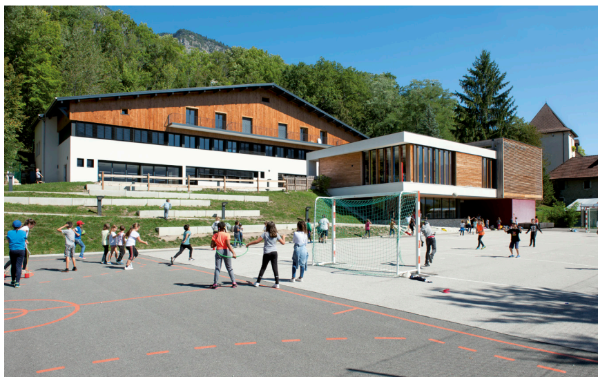
3 - Bâtiment existant et son extension
