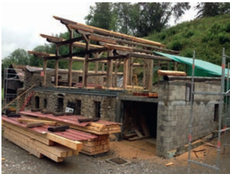
Il a fallu remplacer quelques éléments de charpente...
