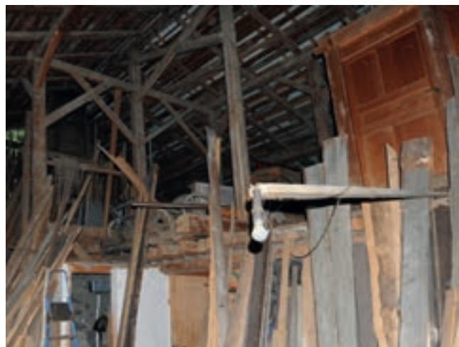
L'intérieur avant les travaux.
