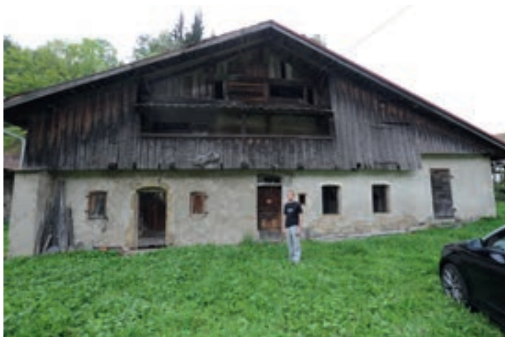
La façade avant les travaux.
